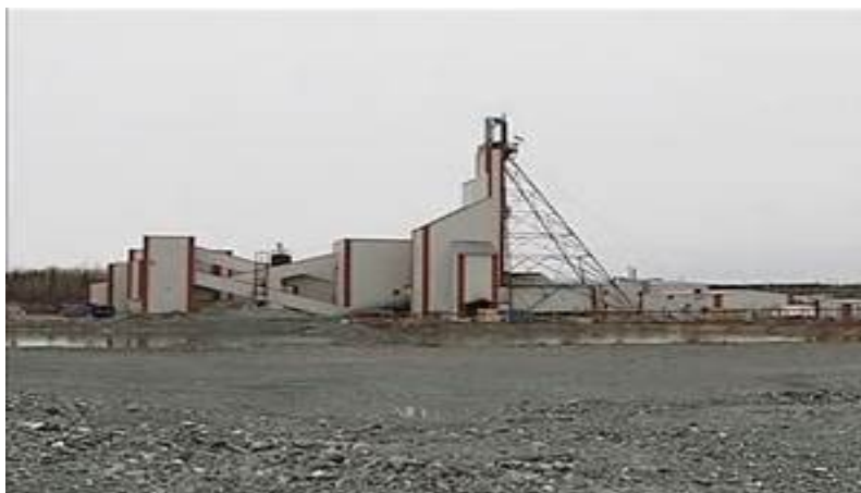
Installation de surface de la mine Géant Dormant
