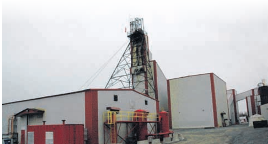
Avant d'envisager la relance des opérations de la mine Géant Dormant, fermée depuis le 7 novembre 2014, Mines Abcourt devra procéder à des réparations au puits no 1. Celui-ci sert d'issue de secours et de conduit de ventilation. (Photo TC Media - Archives)
