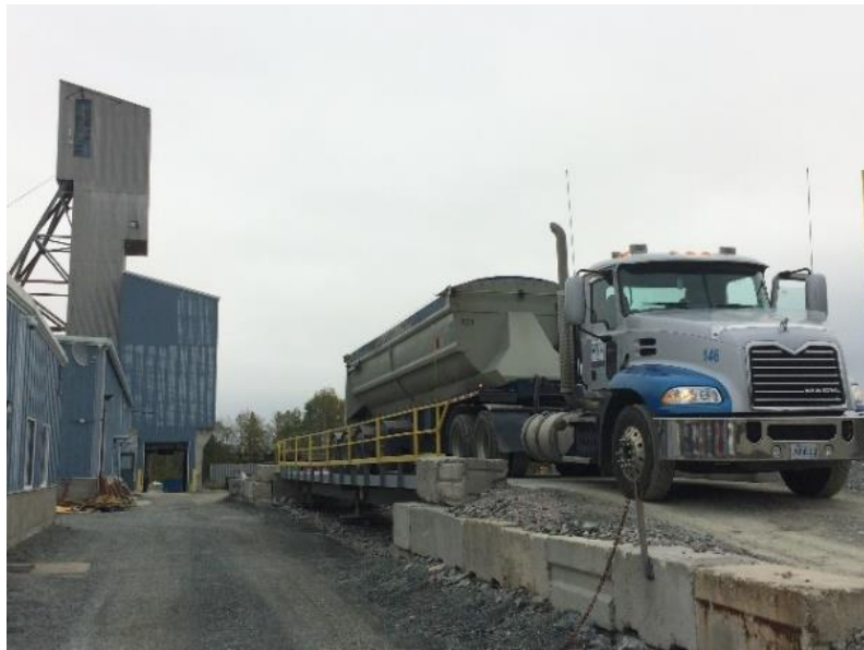
Balance pour camions et chevalement de la mine
